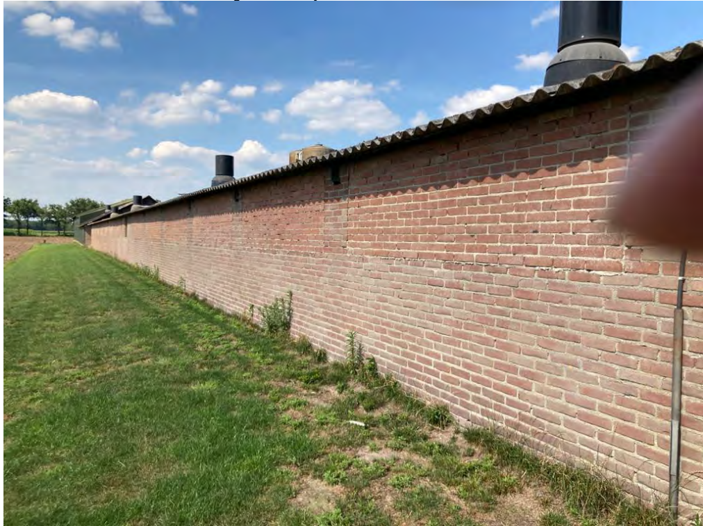
• Afbeelding 23: buitenzijde varkensstallen
