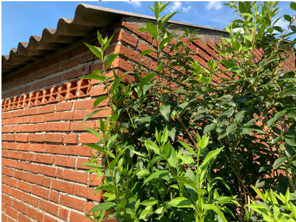
• Afbeelding 4: buitenzijde varkensstallen
