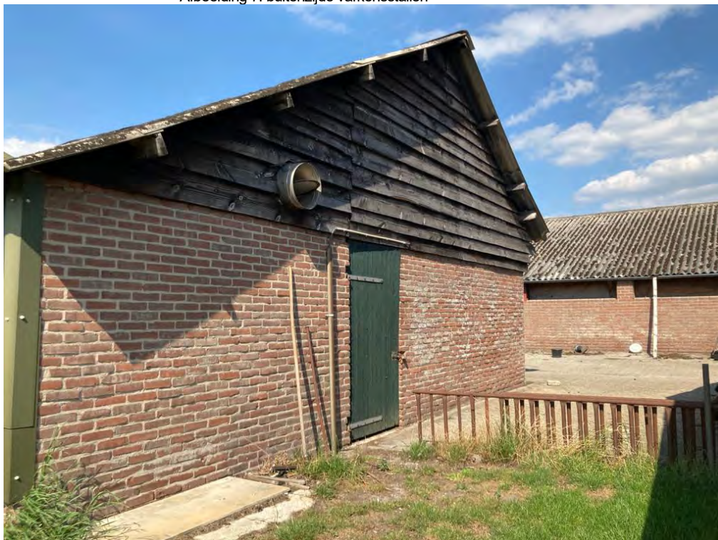
• Afbeelding 7: buitenzijde varkensstallen
