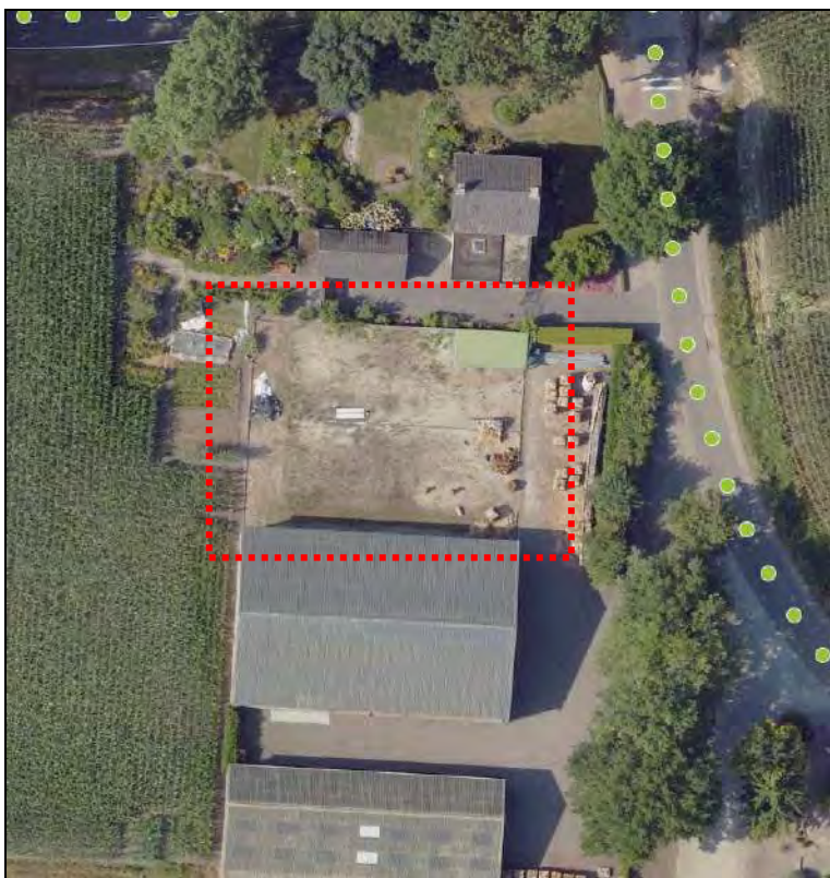
Figuur 13: Luchtfoto in aanbouw zijnde loods
