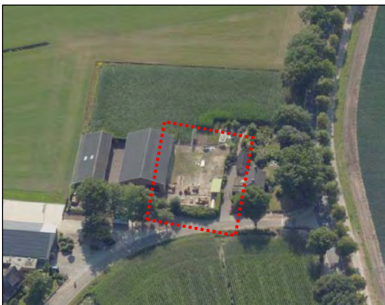
Figuur 14: Luchtfoto in aanbouw zijnde loods
