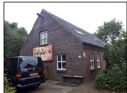
Figuur 5. Werkplaats vanuit zuidoostelijke zijde gezien.
