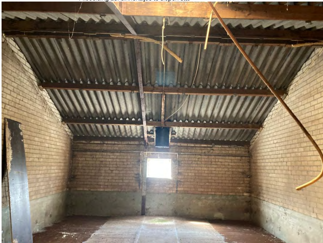
• Afbeelding 15: binnenzijde te slopen stal
