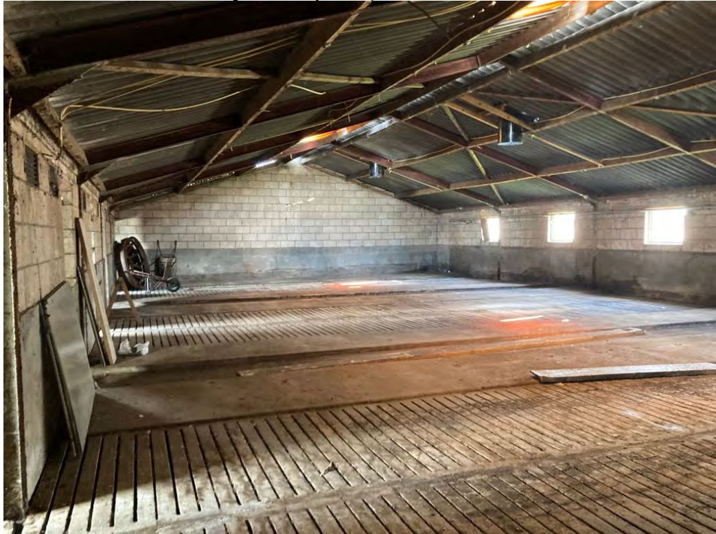
• Afbeelding 16: binnenzijde te slopen stal
