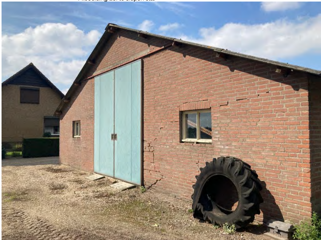
• Afbeelding 13: te slopen stal
