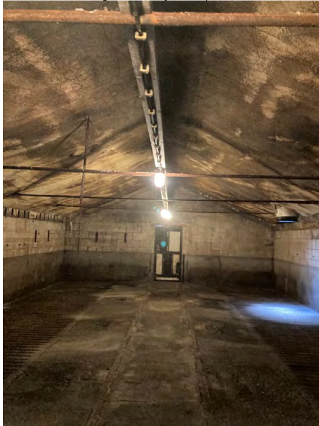
• Afbeelding 10: binnenzijde te slopen stal
