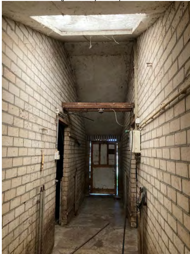
• Afbeelding 9: binnenzijde te slopen stal
