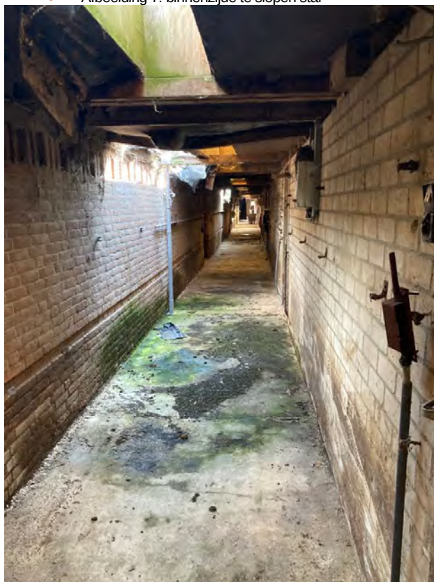
• Afbeelding 7: binnenzijde te slopen stal
