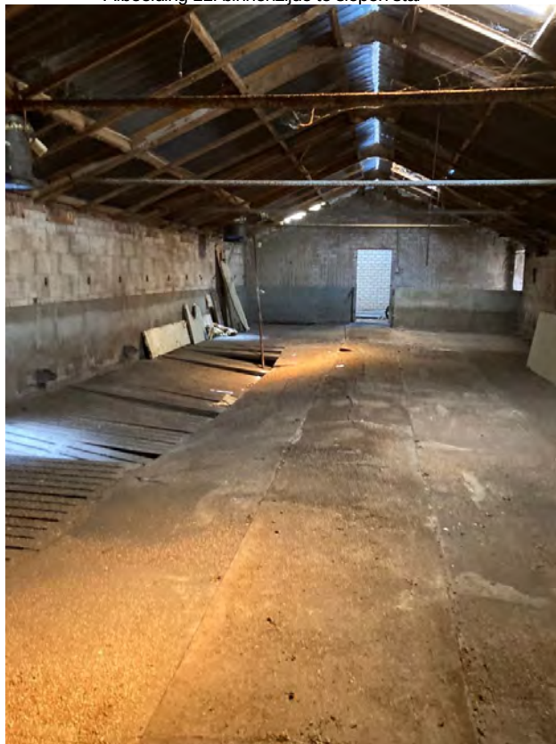
• Afbeelding 11: binnenzijde te slopen stal
