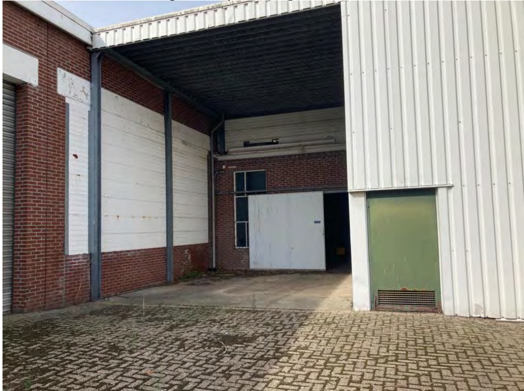
• Afbeelding 10: buitenzijde te slopen gebouw
