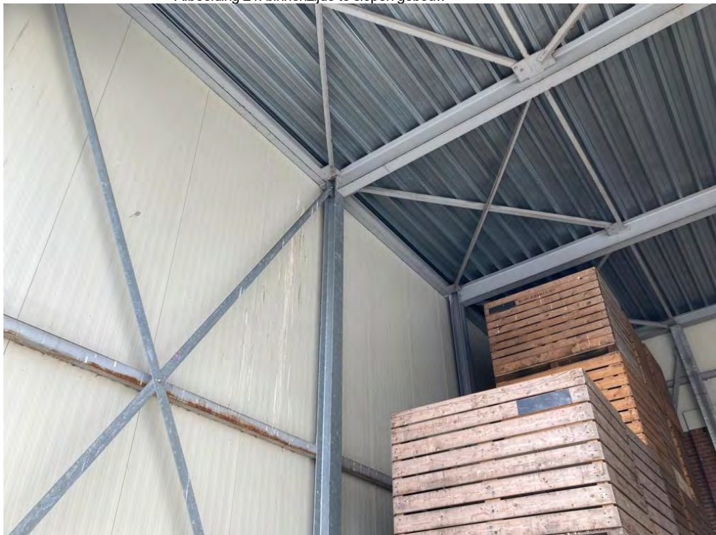
• Afbeelding 21: binnenzijde te slopen gebouw
