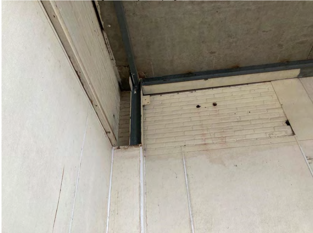
• Afbeelding 24: binnenzijde te slopen gebouw
