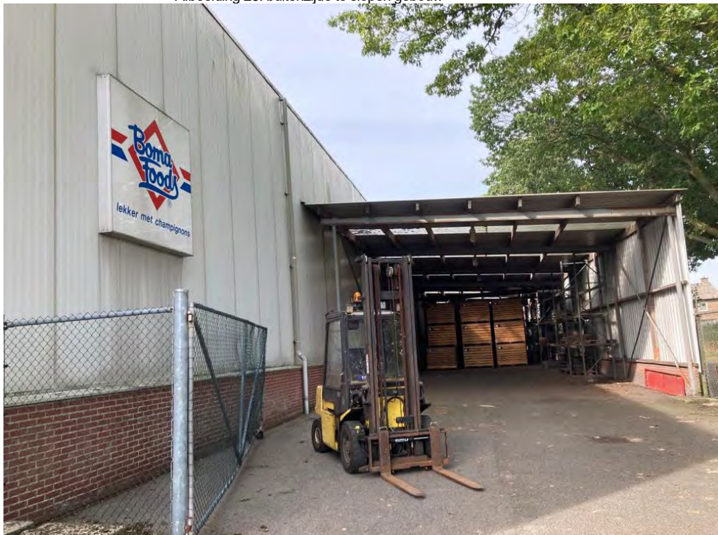
• Afbeelding 25: buitenzijde te slopen gebouw
