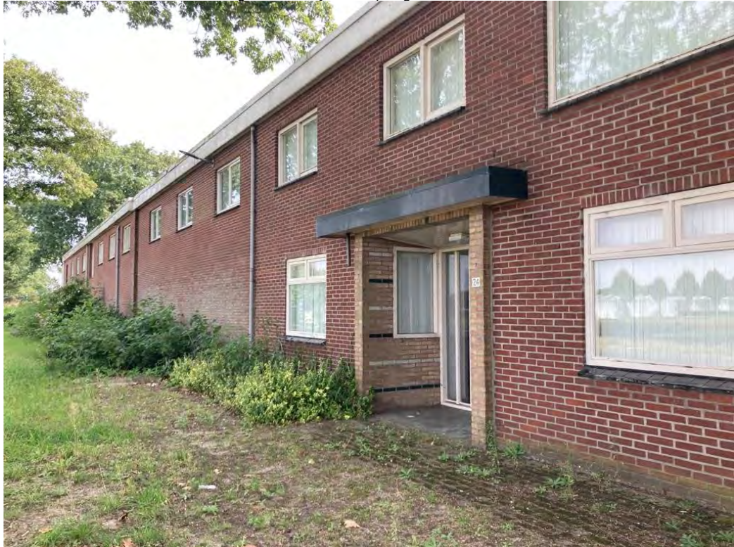
• Afbeelding 20: buitenzijde te slopen gebouw
