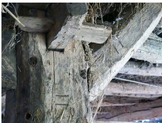
Figuur 82. Het tweede gebint met het telmerk 2 in streepjes, die met de beitel zijn aangebracht. De oostzijde van de gebinten hebben rondjes, de westzijde streepjes.
