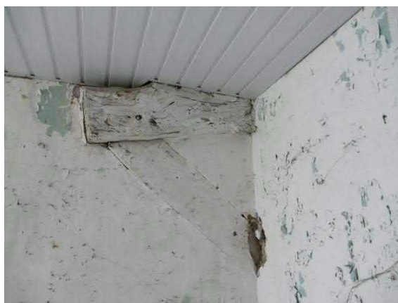
Figuur 74. Uiteinde van kromme stijl in de scheidingsmuur van de twee kamers in krukgedeelte. Om de stijl niet op te laten vallen wordt deze met de muur meegewit.
