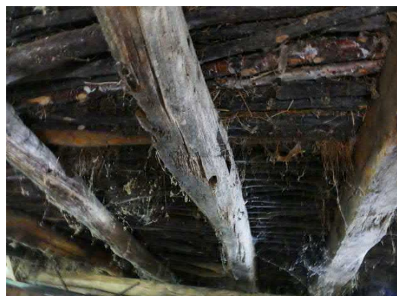
Figuur 83. Het slietenplafond van de stal
