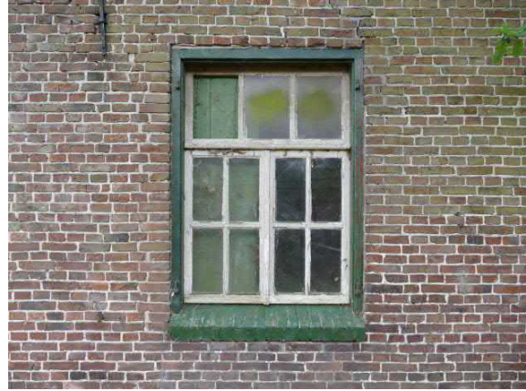
Figuur 48. Huidig raam in westgevel lijkt later aangebracht
