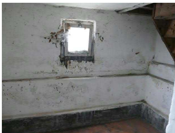
Figuur 64. Kelder met raam in oostgevel. Vloer van rode plavuizen 22 x 22cm. Geheel recht de onderkant van trap naar opkamer
