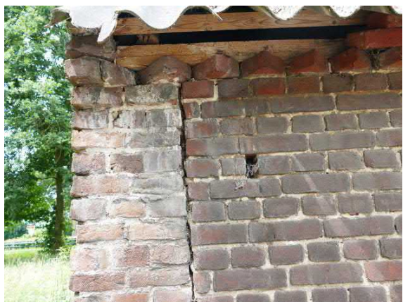
Figuur 56. De aansluiting van de oude zuidgevel met de nieuwe oostgevel
