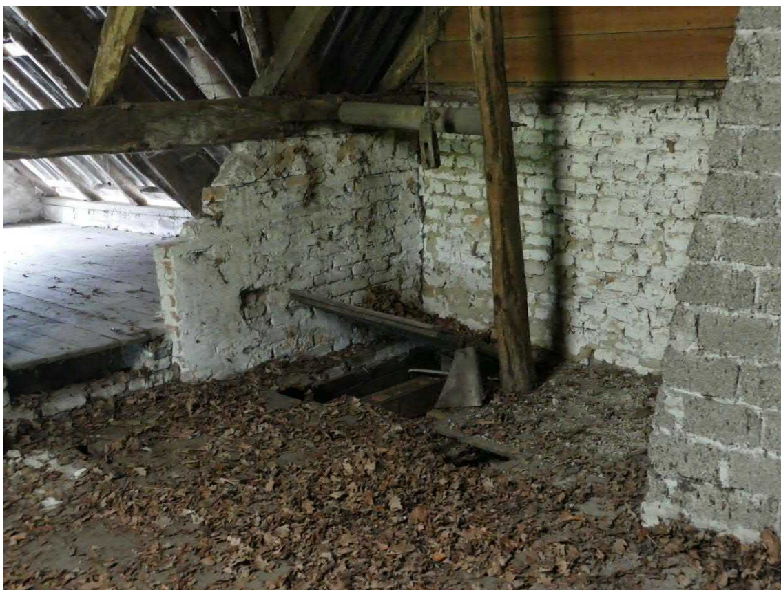
Figuur 1. Door dit luik werden vroeger de zakken graan op zolder gehesen om ze vervolgens te drogen te leggen. Een mooi en bijzonder verschijnsel waarbij het ophaalmechanisme nog volledig in tact is.
