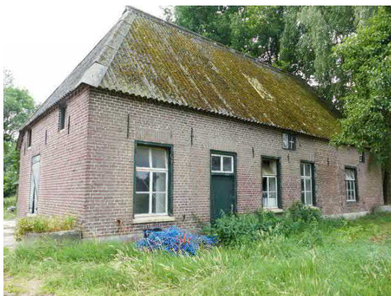
Figuur 41. Voorgevel boerderij
