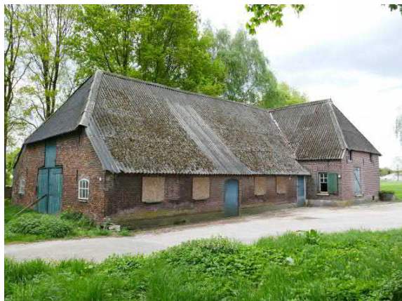
Figuur 52. De stal gezien vanuit het zuidoosten
