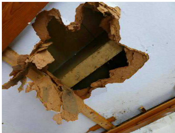
Figuur 67. Onder het verlaagde zachtboardplafond bevindt zich de originele balklaag van de woonkamer (voormalige herd).
