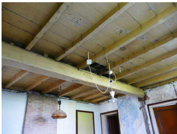
Figuur 68. Het volledig gestripte balkenplafond van de herd
