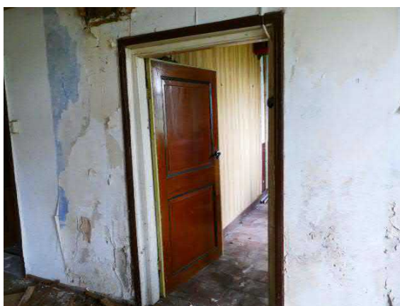
Figuur 32. De paneel deur naar de voorkamer dateert uit 1878 en krijgt in 1925 eveneens een houtnerfimitatie
