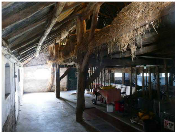
Figuur 80. Overzichtsfoto met op de voorgrond het derde gebint en daarachter het tweede en eerste gebint
