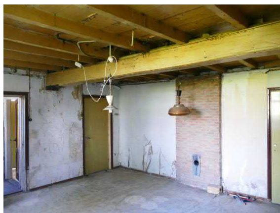
Figuur 14. De fraaiste balk is de moerbalk in de herd
