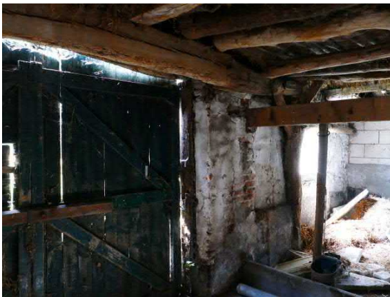
Figuur 35. Het gebint dat dicht tegen de eindgevel staat.
