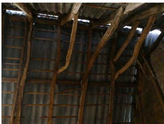
Figuur 15. De stal met het eiken gebint en sporenkap van het hallenhuis
