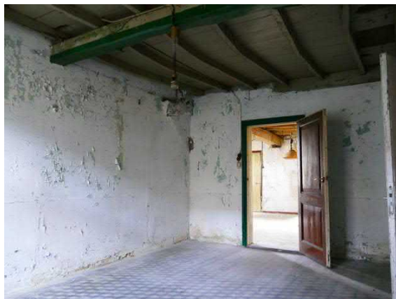
Figuur 72. Het gestripte balkenplafond in de slaapkamer
