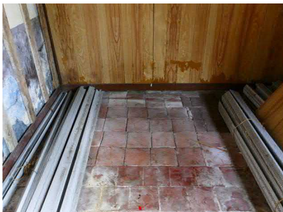
Figuur 70. De in het zand liggende plavuizen (22 x 22cm) markeren de plaats van de verdwenen bedsteewand in de "goei kamer".
