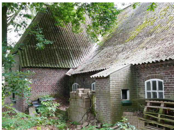
Figuur 54. Westgevel met uitbouw van het privaat
