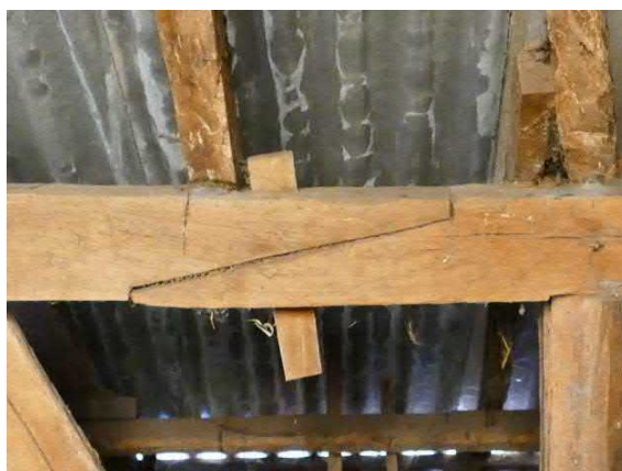
Figuur 76. Een las met wig in de gebintplaat
