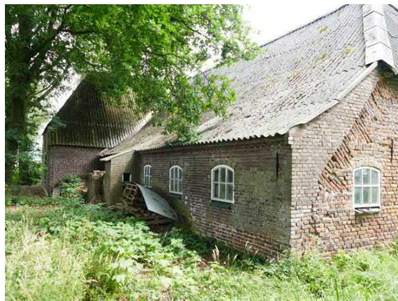
Figuur 53. Stal gezien vanuit het zuidwesten. Aan beide gevels is te zien hoe hoog de oorspronkelijke zijgevel was.
