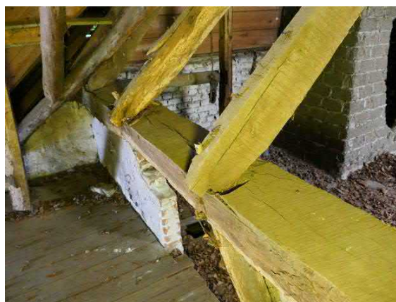
Figuur 77. Bevestiging kasporen in gebintplaat met toognagels
