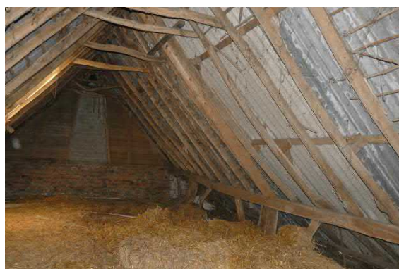
Figuur 89. Sporenkap van stal met achteraan bovenzijde brandgevel. De egale afsluiting van deze gevel en het nieuwe schoorsteenkanaal geven aan dat er oorspronkelijk geen stenen rookafvoer zal zijn geweest.
