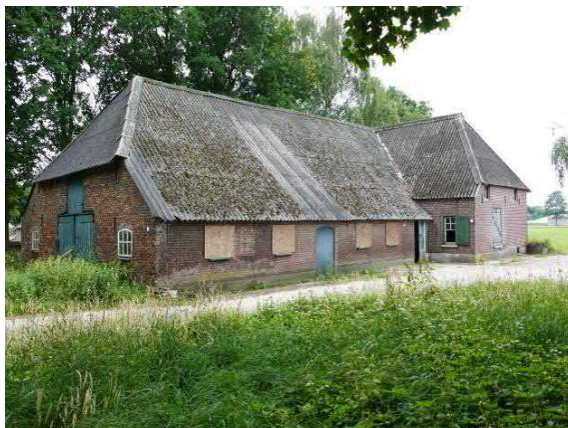
Figuur 11. Het stalgedeelte heeft nog de vorm van het hallenhuis
