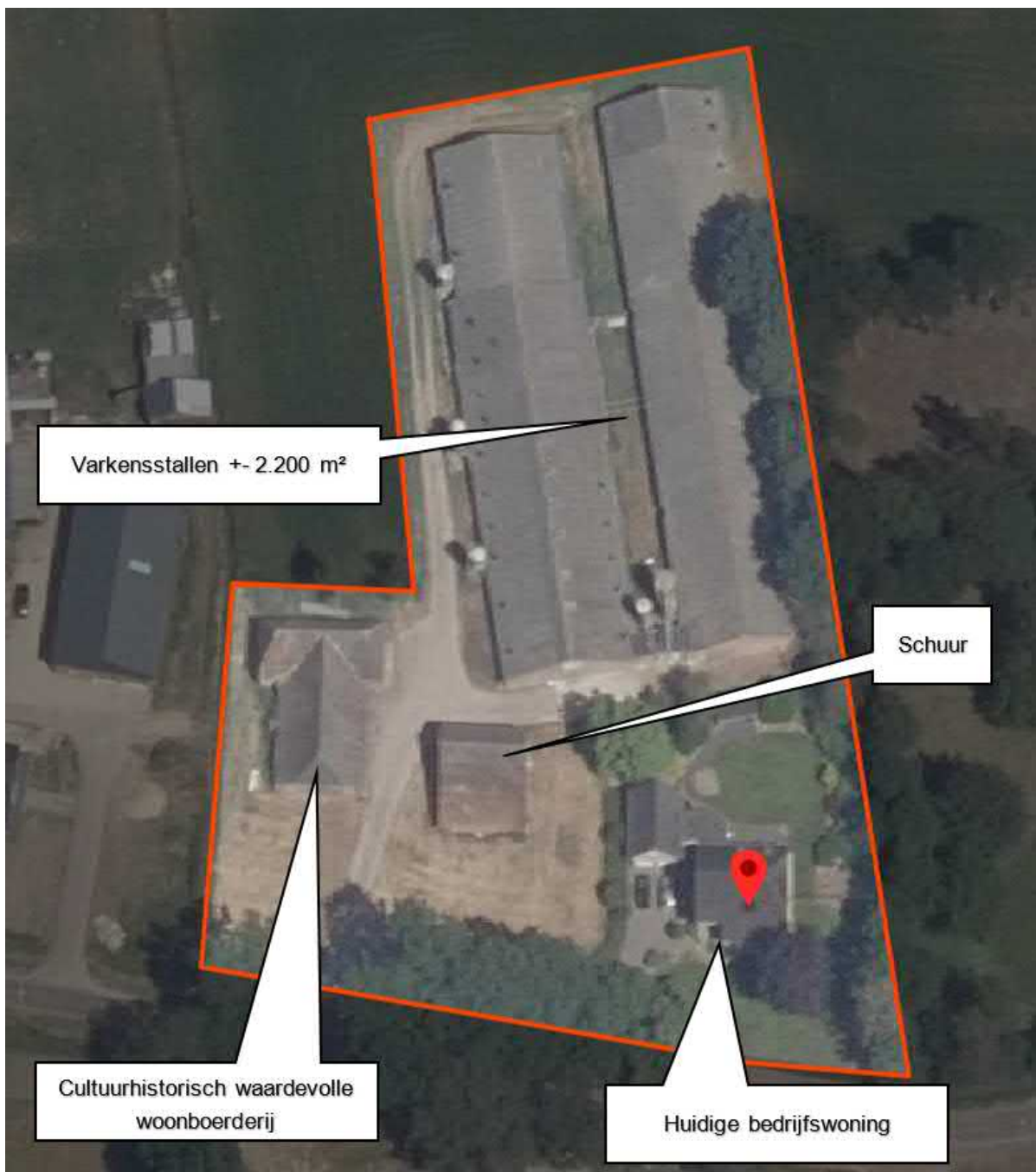
Figuur 4. Luchtfoto huidige situatie Leurke 5 (bron: www.ruimtelijkeplannen.nl ).
