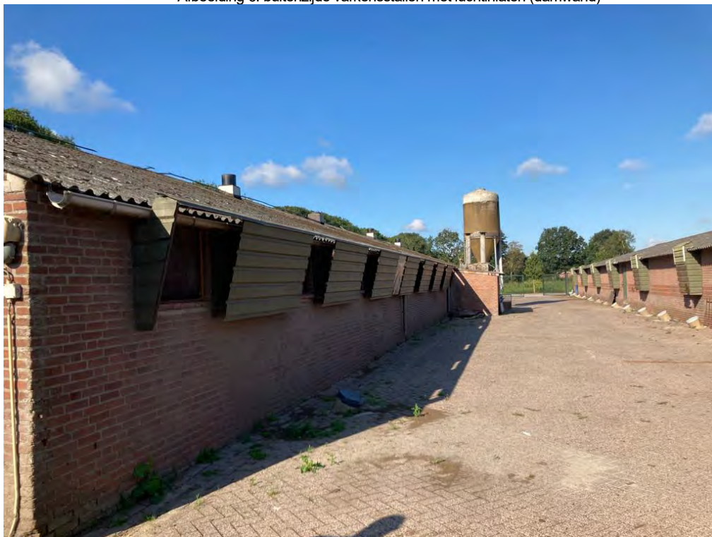
• Afbeelding 6: buitenzijde varkensstallen met luchtinlaten (damwand)
