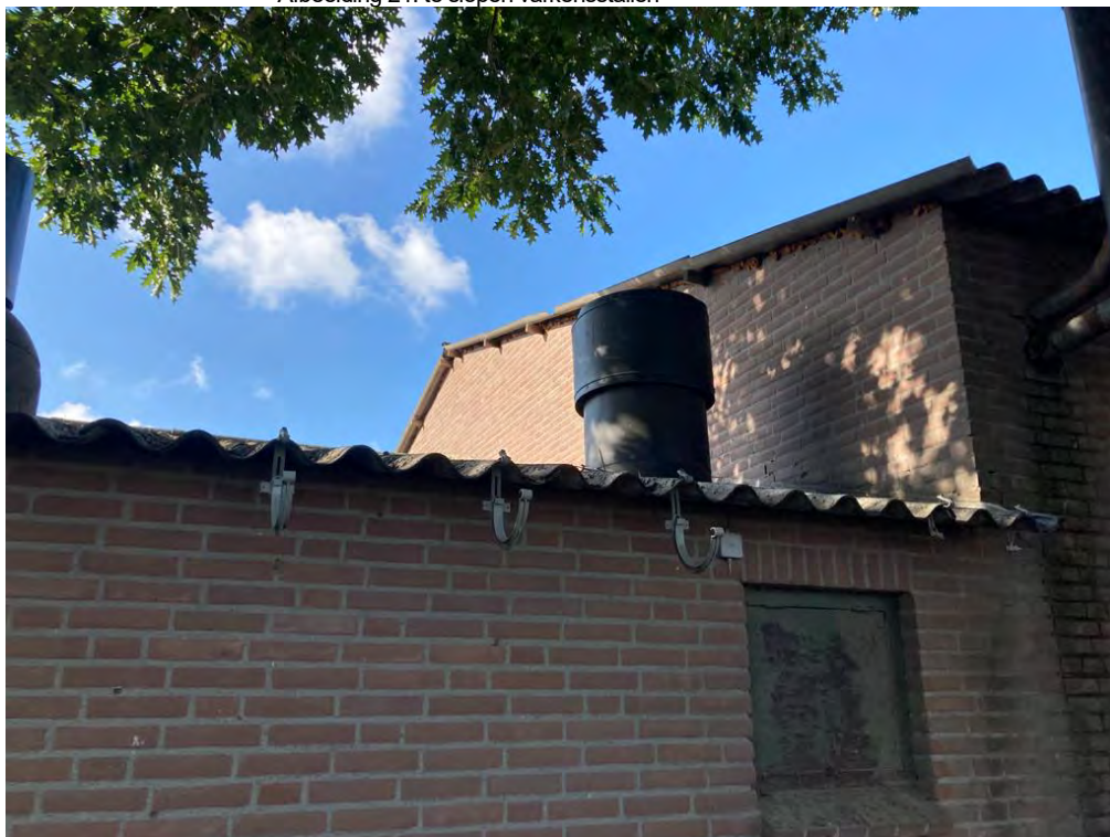
• Afbeelding 21: te slopen varkensstallen
