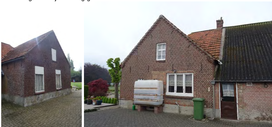
Afbeelding 7 en 8: Bestaande te slopen voormalige bedrijfswoning. Bron: R.J.L. Bijvelds 20-05-2021
