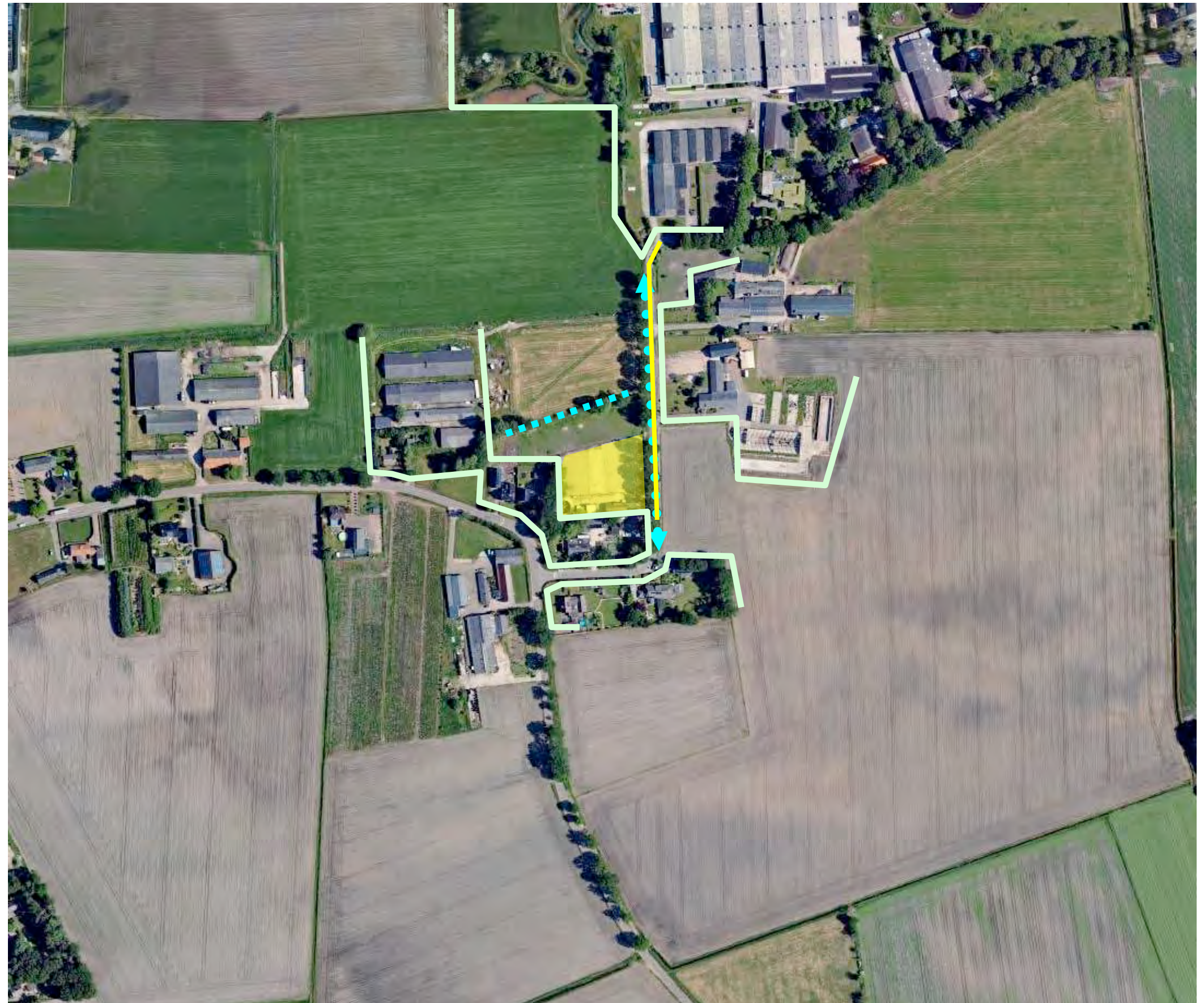
het plangebied wordt waargenomen van de weg Vosdeel
