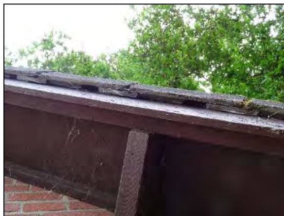
Figuur 12. Ruimte langs de dakranden geeft vleermuizen toegang tot ruimte onder de dakpannen.
