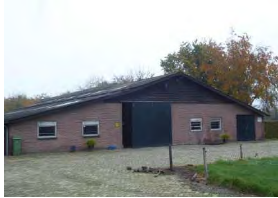
Afbeelding 3. Voorzijde van de melkschuur (foto vanuit de oprit, gekeken naar het westen).
