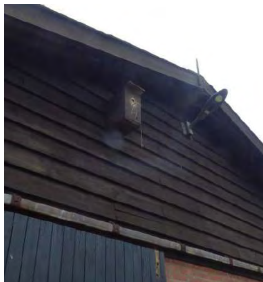
Afbeelding 9. Een van de nestkasten waarin huismus broedt. De nestkast hangt aan de voorzijde van de melkschuur (foto genomen vanuit deelgebied 1).
