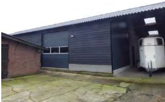
Afbeelding 4. Paardenstal met gesloten en open gedeelte, open gedeelte aan de rechterkant vormt een kapschuur (foto van de noordzijde).
