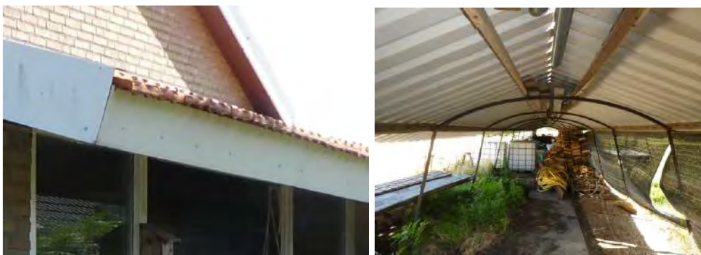
Afbeelding 7 en 8: geen nesten/ nestlocaties van huismussen aangetroffen in de te slopen bebouwing. Bron: BNL advies. Datum: 28-07-2022
