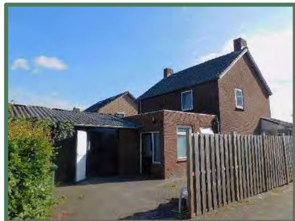
Achterzijde woning met aangebouwde varkensstal
