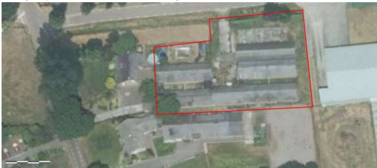
Figuur 2-3: Luchtfoto situatie plangebied
