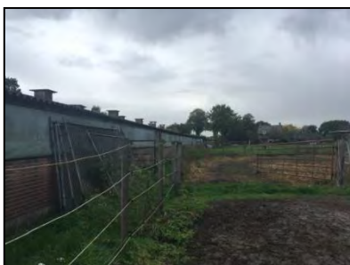
Figuur 9. Noordwest zijde van de achterste stal met een deel van het weiland.
