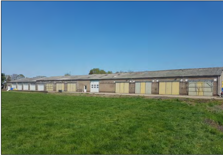
Figuur 4: Bedrijfsgebouw gezien vanuit westelijk oogpunt
