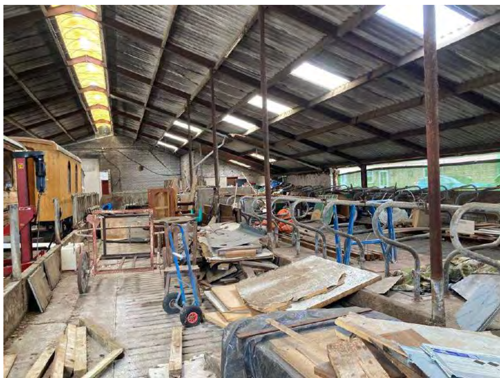
• Afbeelding 14: binnenzijde te slopen ligboxenstal
