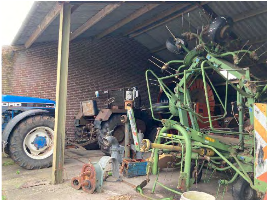
• Afbeelding 6: Te slopen loods achter voormalige varkensstal
