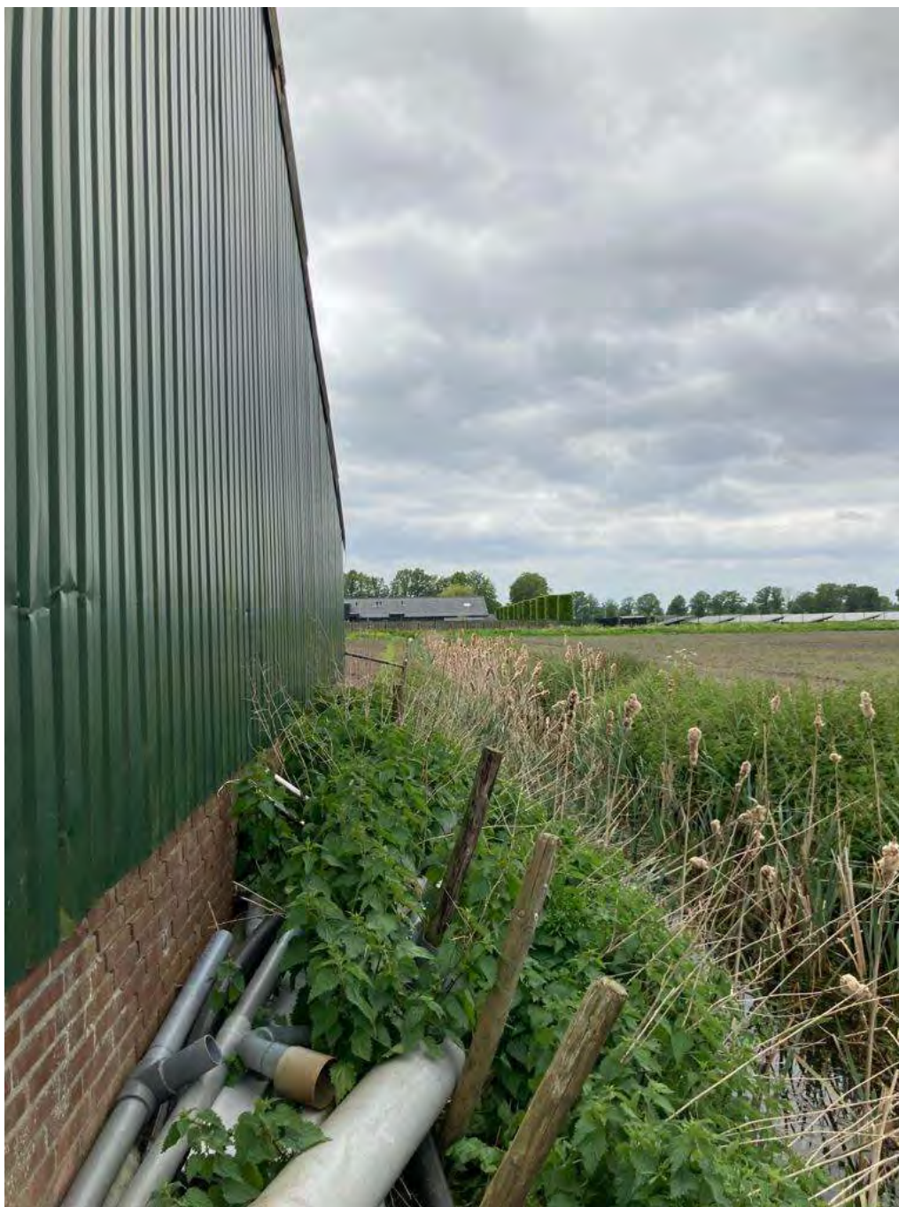
• Afbeelding 10: Sloot naast te slopen loods
