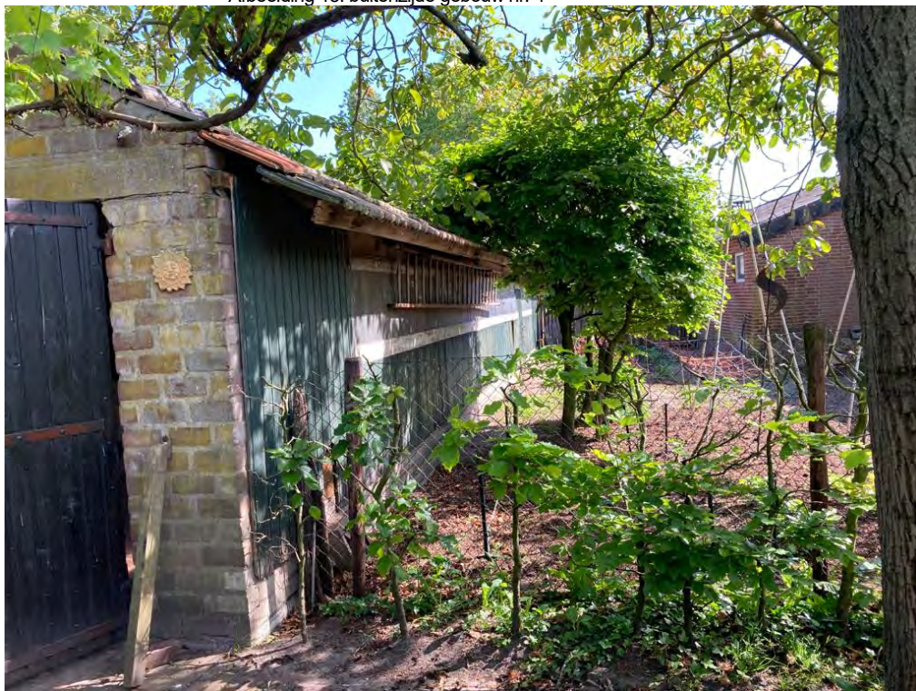
• Afbeelding 15: buitenzijde gebouw nr. 4
