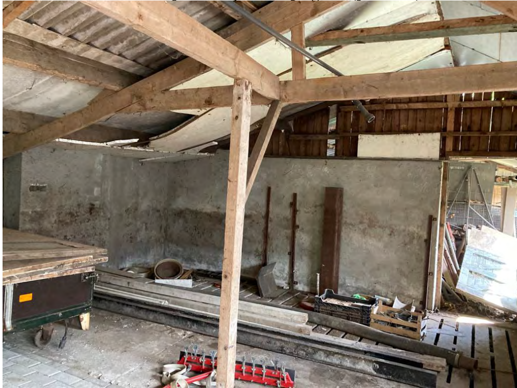
• Afbeelding 12: binnenzijde voormalige kippenstal (gebouw nr. 4)
