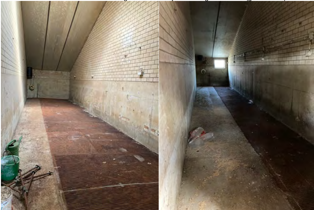
• Afbeelding 6 en 7: binnenzijde voormalige varkensstal (gebouw nr. 3)
