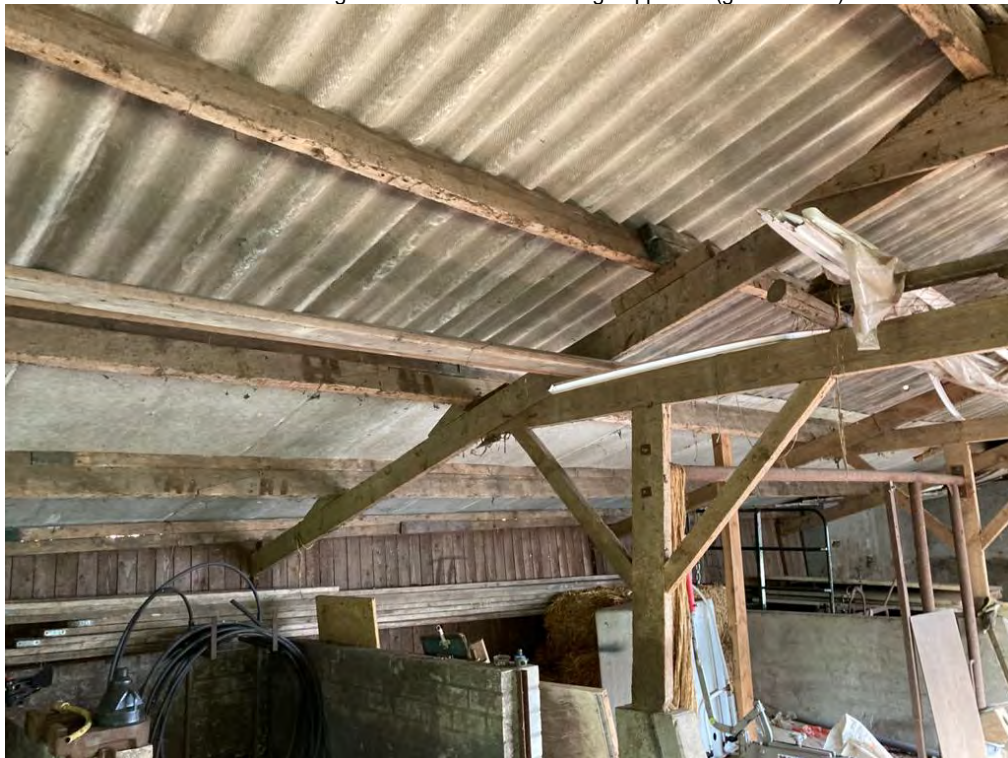
• Afbeelding 14: dakconstructie voormalige kippenstal (gebouw nr. 4)
