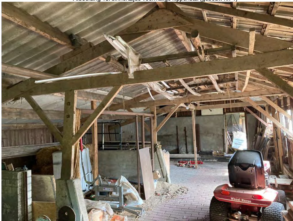
• Afbeelding 13: binnenzijde voormalige kippenstal (gebouw nr. 4)
