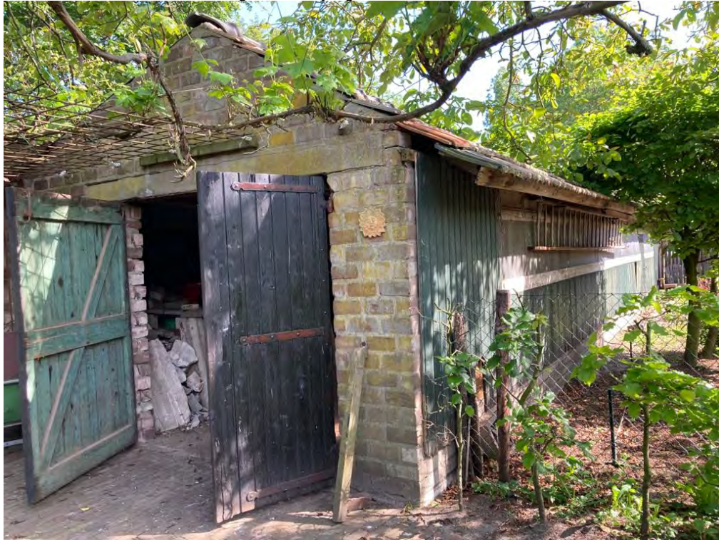
• Afbeelding 16: buitenzijde gebouw nr. 4
