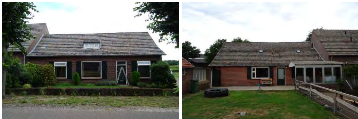
Afbeelding 3 en 4: Bestaande te slopen woning op het kavel. Bron: R.J.L. Bijvelds 20-08-2020
