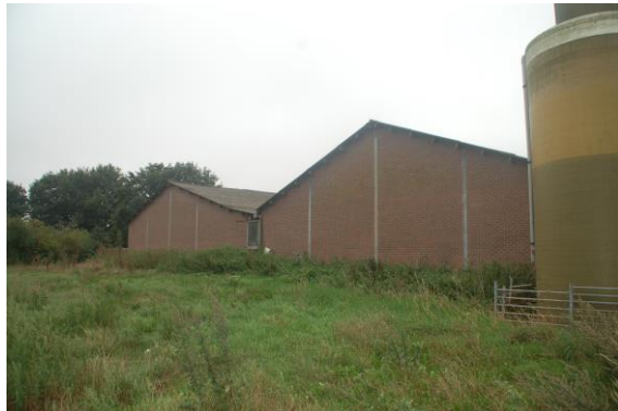
Afbeelding: achterzijde te slopen stallen.
