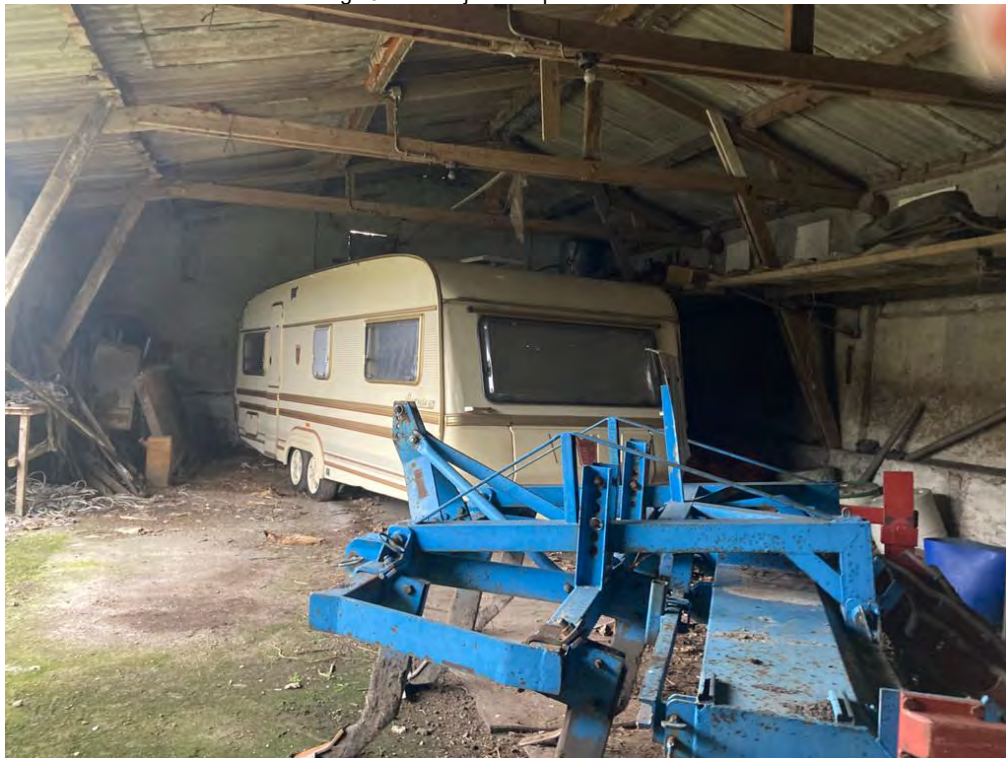
• Afbeelding 25: binnenzijde te slopen schuur
