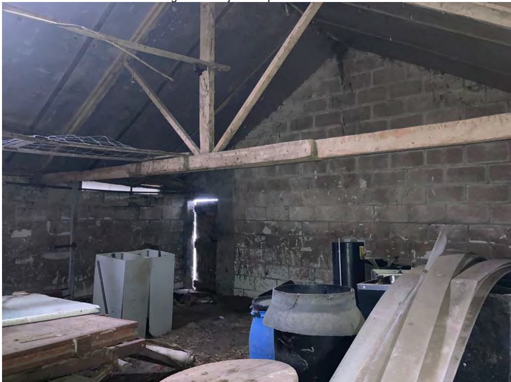
• Afbeelding 4: binnenzijde te slopen varkensstal
