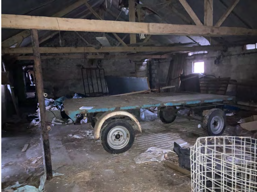
• Afbeelding 3: binnenzijde te slopen voorste varkensstal
