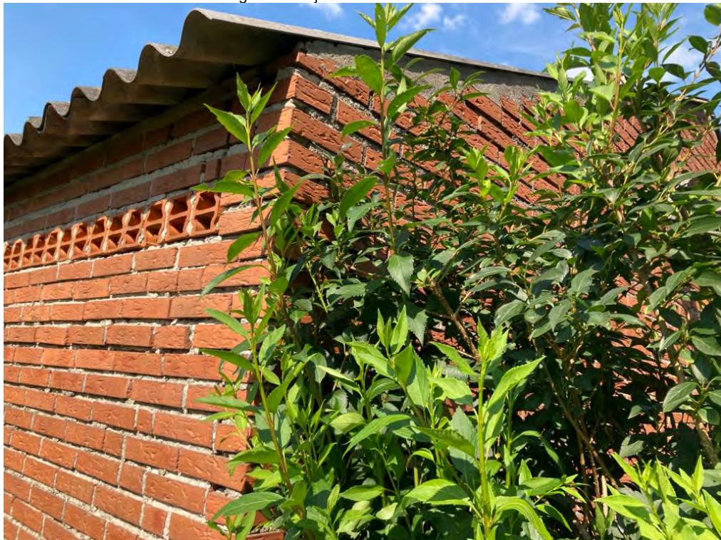
• Afbeelding 4: buitenzijde varkensstallen
