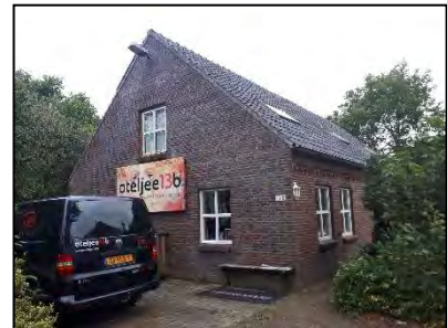
Figuur 5. Werkplaats vanuit zuidoostelijke zijde gezien.
