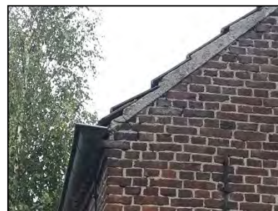
Figuur 13. Ruimte onder dakpannen te bereiken via de dakgoot.
