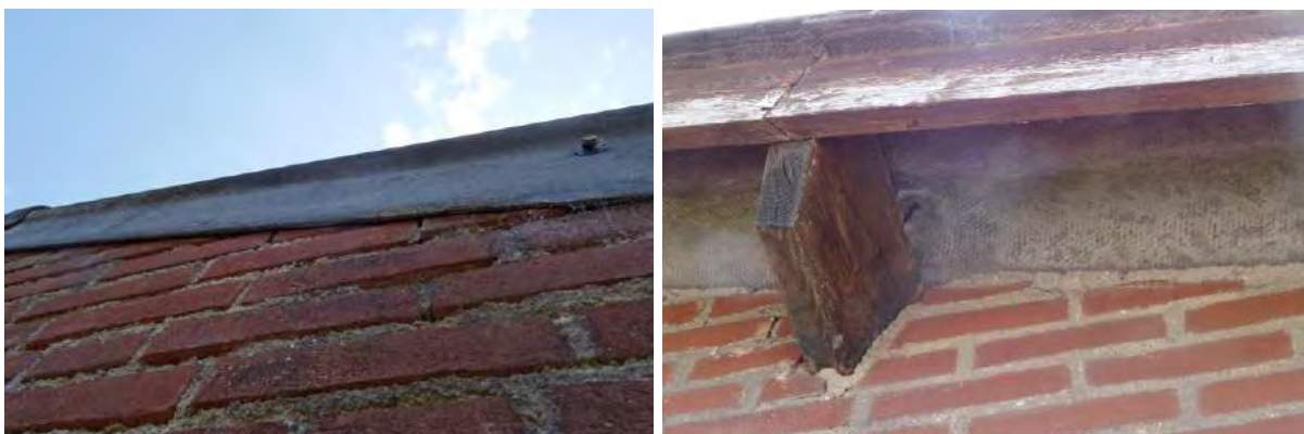
Afbeelding 11 en 12: Daken sluiten goed aan op de hoofdbouw, waardoor vleermuizen geen toegang tot mogelijk geschikte verblijfruimten hebben. Bron: R.J.L. Bijvelds 17-06-2021
