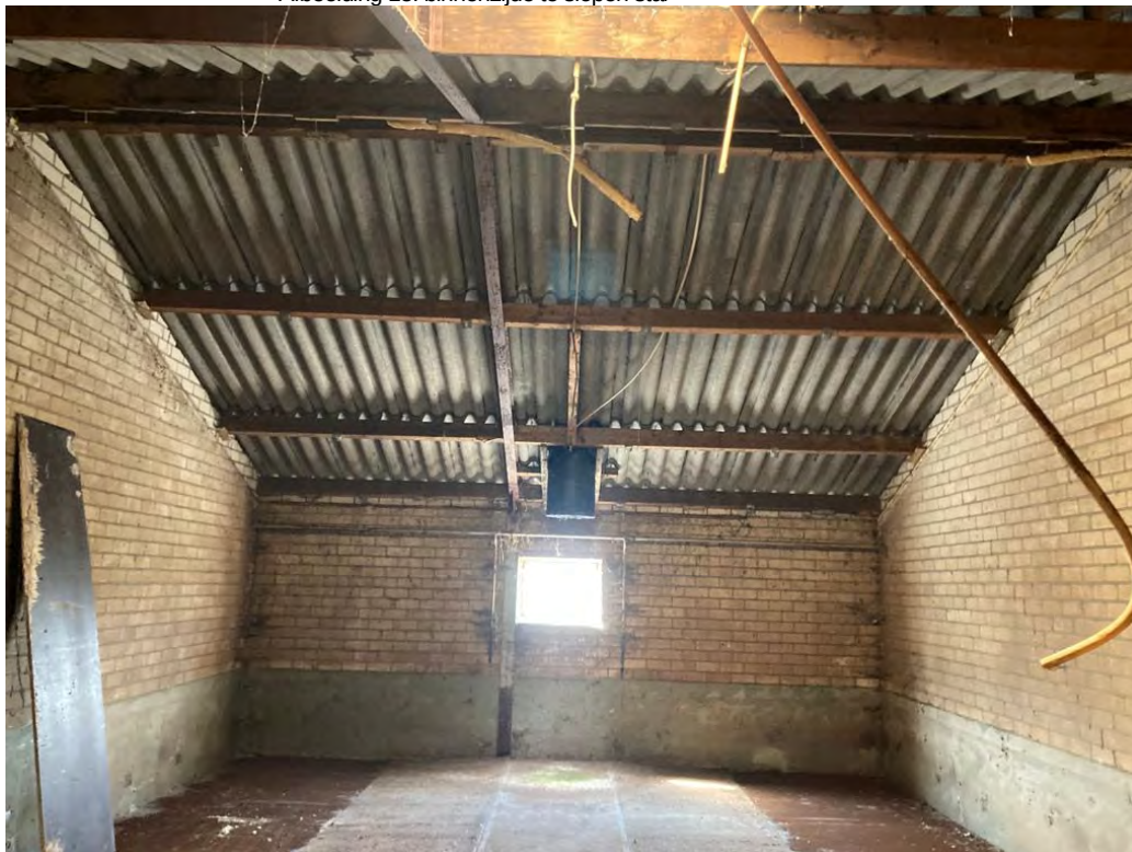
• Afbeelding 15: binnenzijde te slopen stal
