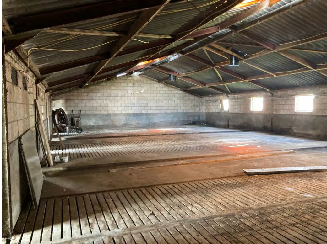
• Afbeelding 16: binnenzijde te slopen stal
