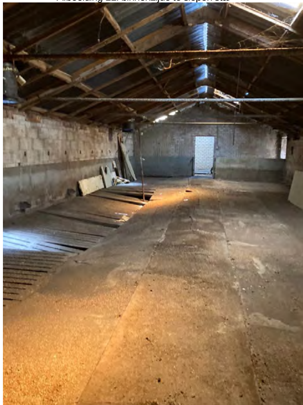
• Afbeelding 11: binnenzijde te slopen stal
