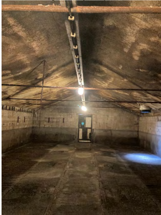
• Afbeelding 10: binnenzijde te slopen stal
