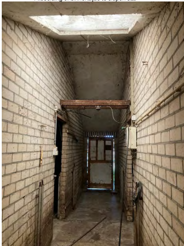
• Afbeelding 9: binnenzijde te slopen stal
