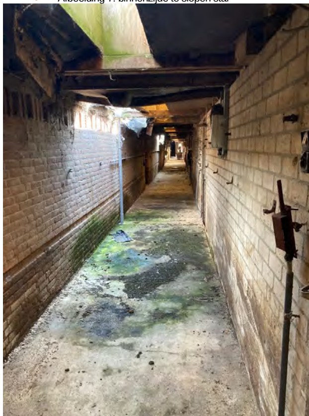
• Afbeelding 7: binnenzijde te slopen stal
