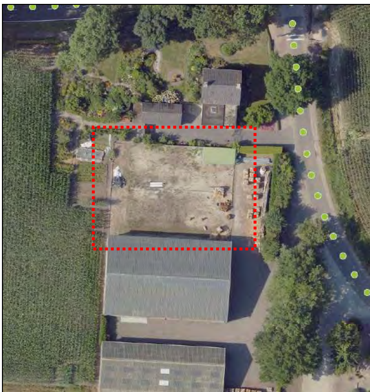
Figuur 13: Luchtfoto in aanbouw zijnde loods
