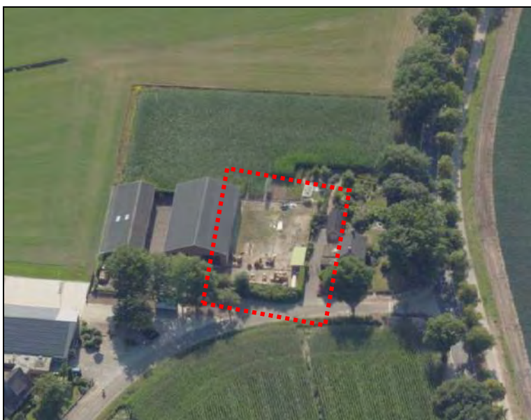
Figuur 14: Luchtfoto in aanbouw zijnde loods
