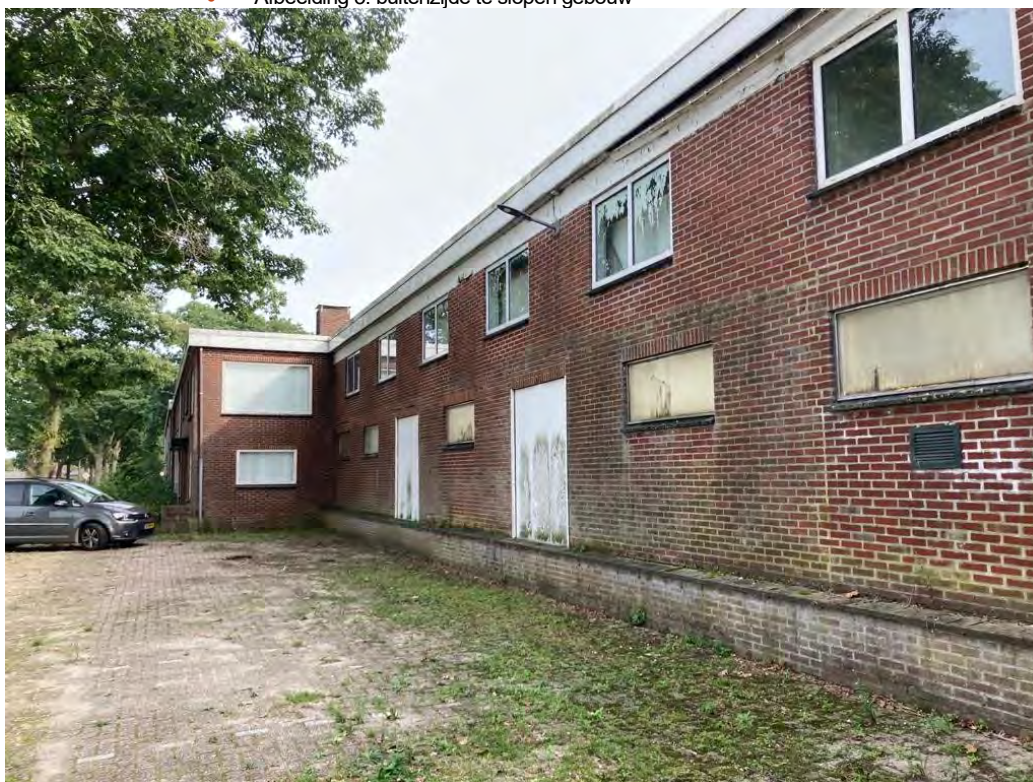
• Afbeelding 3: buitenzijde te slopen gebouw
