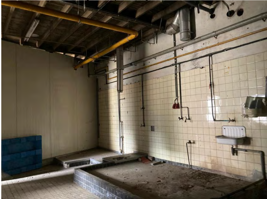
• Afbeelding 4: binnenzijde te slopen gebouw
