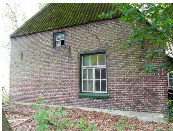
Figuur 44. Westgevel van woongedeelte (krukaanbouw)
