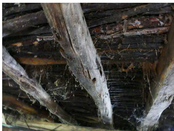
Figuur 83. Het slietenplafond van de stal
