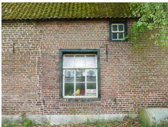
Figuur 22. Links de voorgevel van het hallenhuis en rechts de nieuwe aanbouw van het krukhuis.
