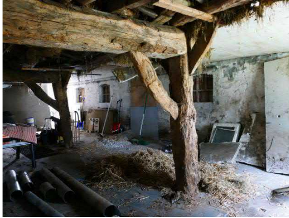
Figuur 33. Het tweede en derde gebint van de stal
