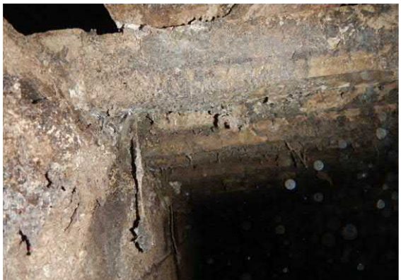
Betonnen roosters op gemetselde putten
