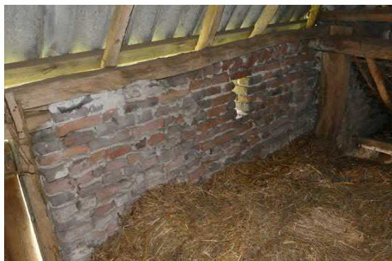
Figuur 86. Het uilengat in de eindgevel
