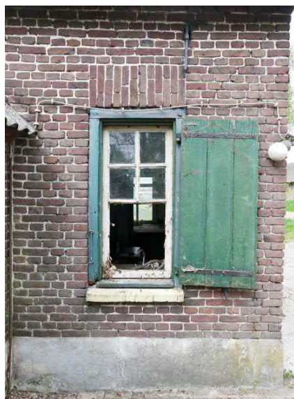
Figuur 46. Halfvenster in zuidgevel van woongedeelte. Het kozijn is houtgepend
