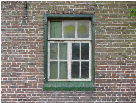
Figuur 48. Huidig raam in westgevel lijkt later aangebracht
