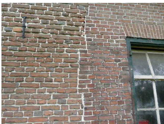
Figuur 43. Het ingeboete deel van de voorgevel. Links muurdeel van 1804, rechts 1875
