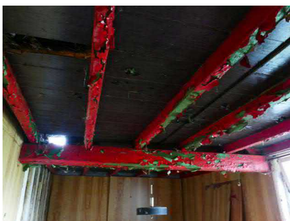
Figuur 24. Balkenplafond van "goeie kamer" in Krukaanbouw.
