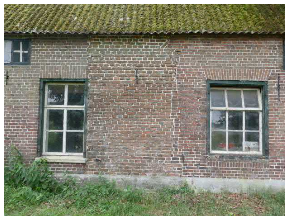
Figuur 42. De drie fasen van de voorgevel met links 1925, midden 1804 en rechts 1878
