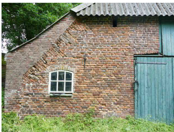
Figuur 13 Bij de eindgevel is aan de vlechtingen te zien dat de zijgevel van het hallenhuis erg laag is
