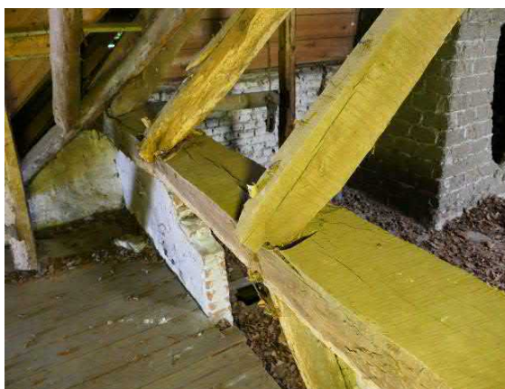
Figuur 77. Bevestiging kapsporen in gebintplaat met toognagels
