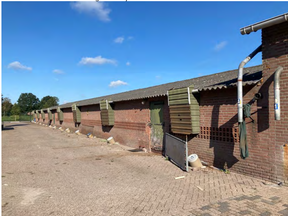
• Afbeelding 7: buitenzijde varkenstallen
