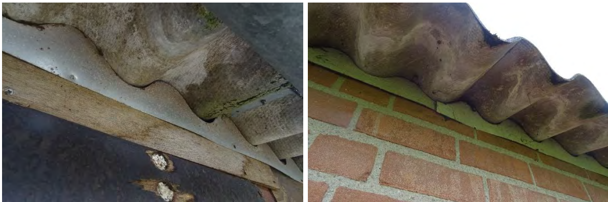
Afbeelding 9 en 10: Daken van de stallen en bijgebouwen zijn niet toegankelijk voor huismussen door de aanwezigheid van vogelschroot. Bron: R.J.L. Bijvelds 20-05-2021
