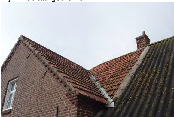
Afbeelding 16 en 17: Geen mogelijk geschikte invliegopeningen in de te slopen voormalige bedrijfswoning. De dakpannen zijn dichtgemaakt met cement. Bron: R.J.L. Bijvelds 20-05-2021
