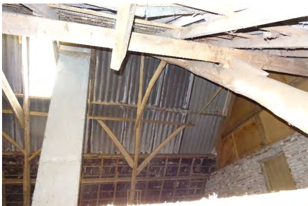
Afbeelding 13 t/m 15: Geen mogelijk geschikte verblijfplaatsen van vleermuizen door de afwezigheid van dakbeschot in de stallen, spouw en overstek/ gevelbekleding is aan de onderzijde afgesloten. In de stallen waar wel isolatie aanwezig is, zijn de daken afgesloten met vogelschroot. Bron: R.J.L. Bijvelds 20-05-2021
