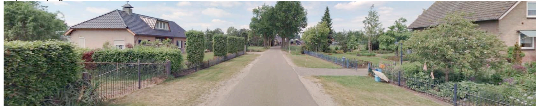
2) tweezijdig bebouwde passage
