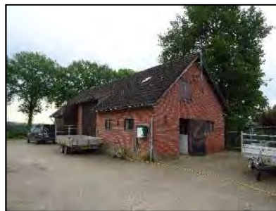
Figuur 4. Stal op de onderzoekslocatie.
