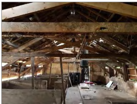
Afbeelding 2.4 | Binnenzijde kleine varkensschuur.
