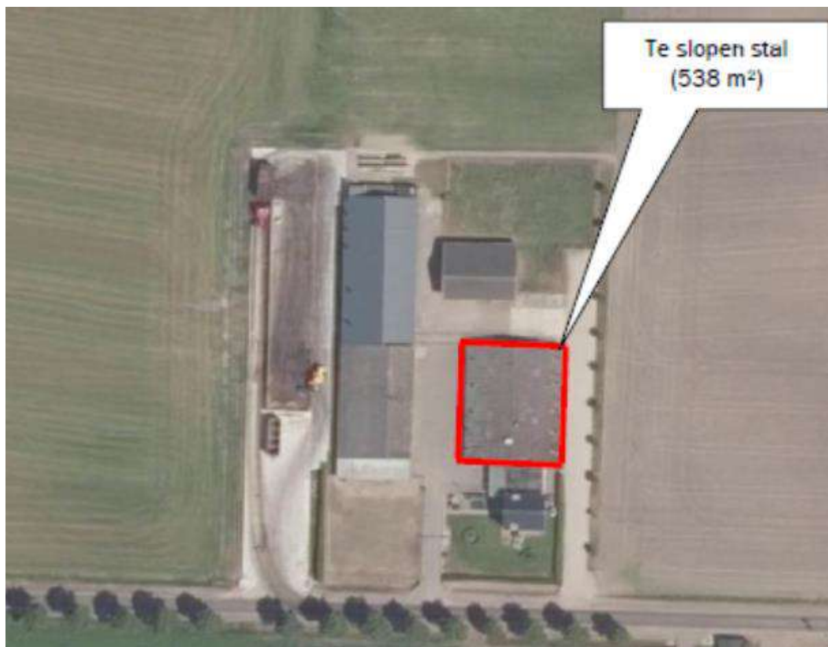
Figuur 177 Schepersedijk 1, te slopen varkensstal
