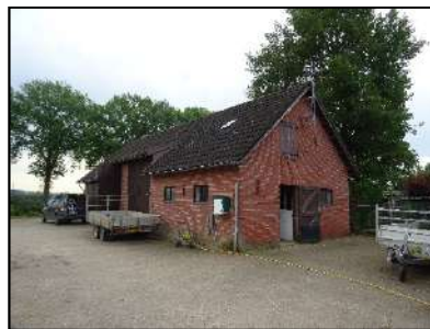
Figuur 4. Stal op de onderzoekslocatie.
