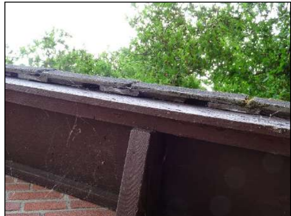
Figuur 12. Ruimte langs de dakranden geeft vleermuizen toegang tot ruimte onder de dakpannen.
