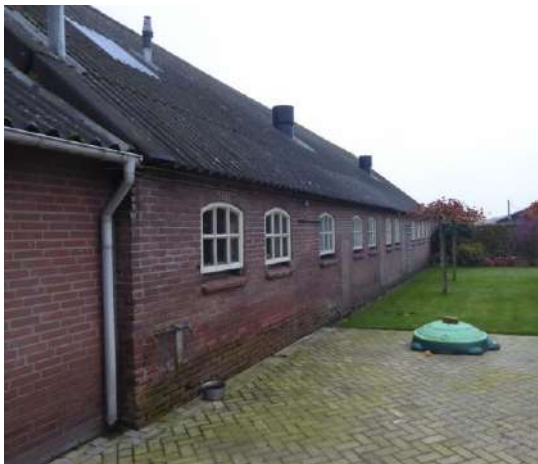
Afbeelding 6. Zijaanzicht en connectiepunt van de varkensstal aan het woonhuis (foto van noordzijde varkensstal).
