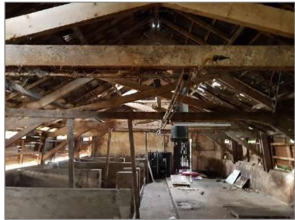
Afbeelding 2.4 | Binnenzijde kleine varkensschuur.
