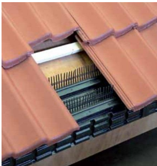
Figuur. De zogenaamde vogelvide of vergelijkbare uitvoeringen geven wel de mogelijkheid voor het maken van nesten, maar zorgt ervoor dat er geen van buiten af door dieren bereikbare ruimten in gebouwen zijn.
