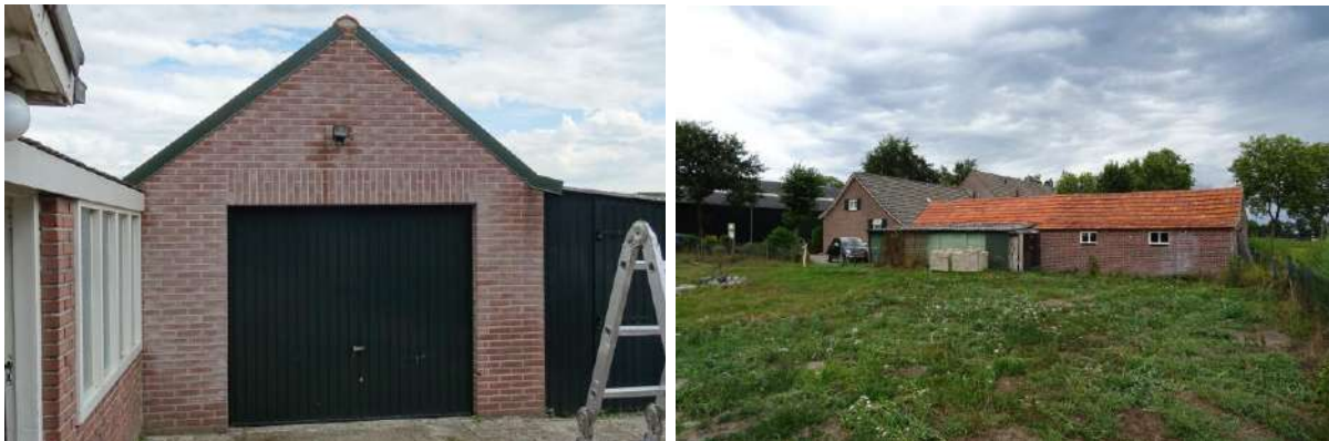
Afbeelding 5 en 6: Bestaande te slopen garage/ schuur. Bron: Rik Bijvelds Datum: 20-08-2020
