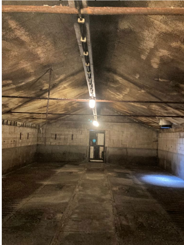
• Afbeelding 10: binnenzijde te slopen stal
