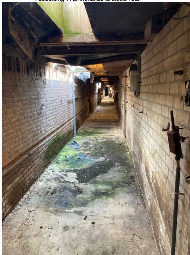
• Afbeelding 7: binnenzijde te slopen stal
