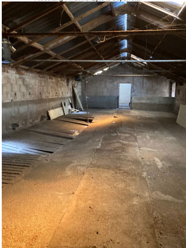
• Afbeelding 11: binnenzijde te slopen stal
