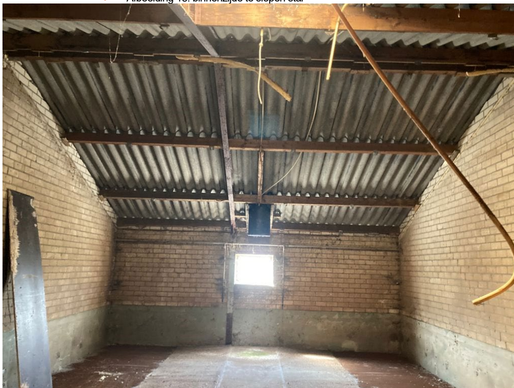
• Afbeelding 15: binnenzijde te slopen stal
