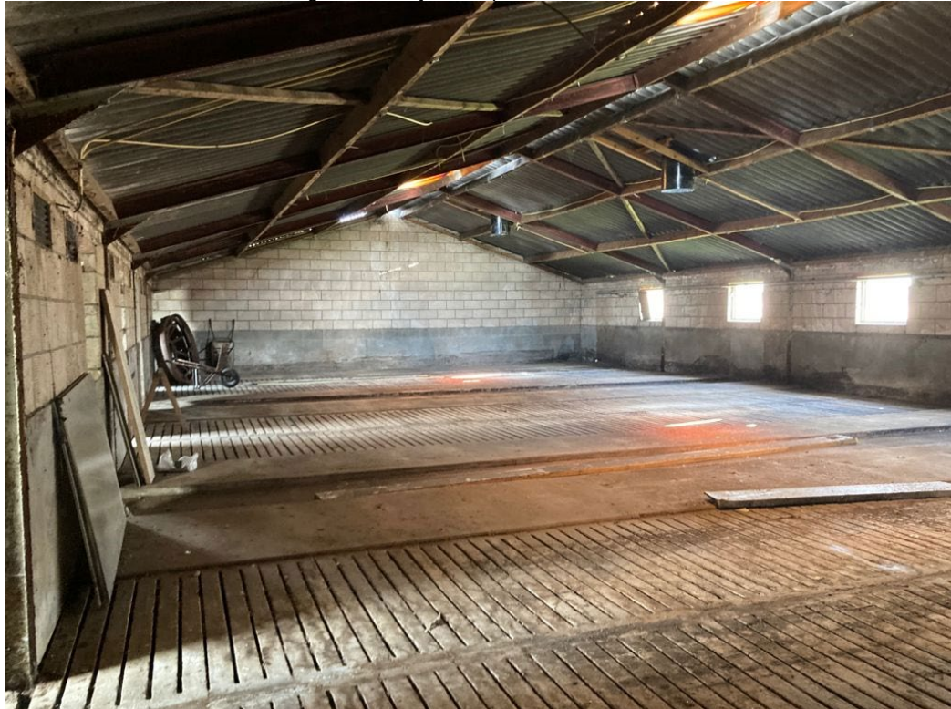
• Afbeelding 16: binnenzijde te slopen stal
