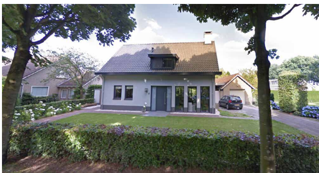
Figuur 8: Daandelendennen gemoderniseerd (bron: streetview)
