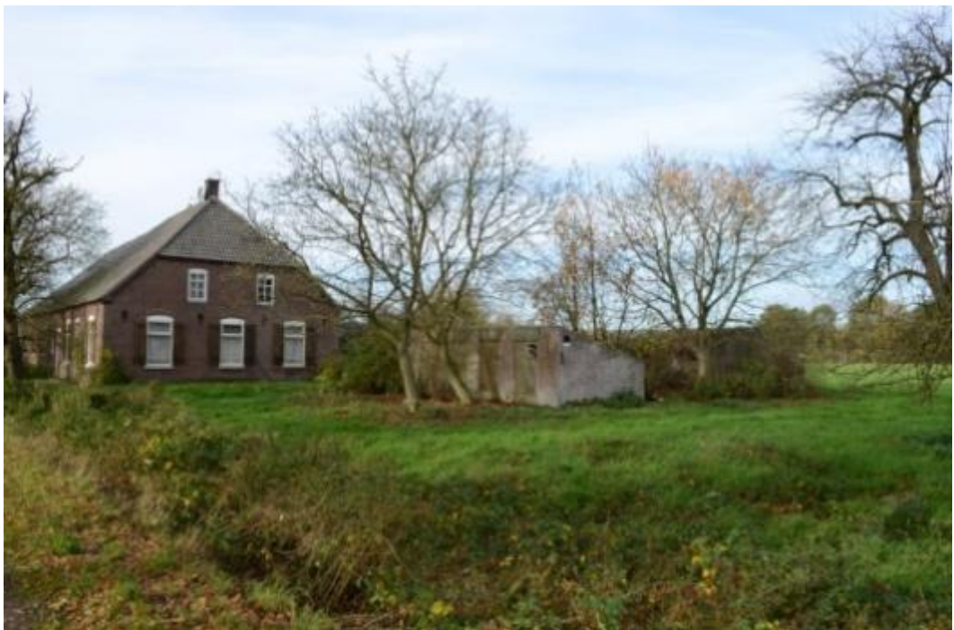
Figuur 2: Asbesthoudende bebouwing op perceel Mutshoek 2
