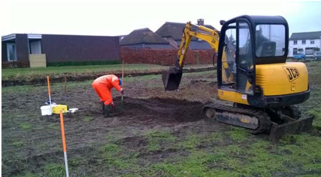
Afbeelding 5.1: Machinaal graven asbest inspectiesleuven RE1
