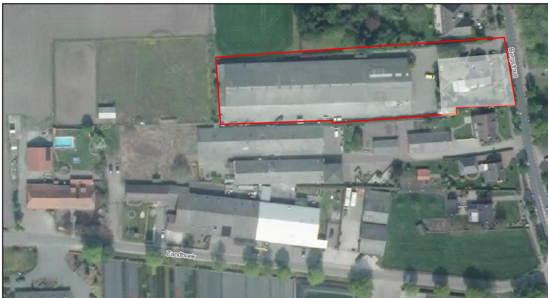
Figuur 16: Luchtfoto locatie Bergstraat 62A
