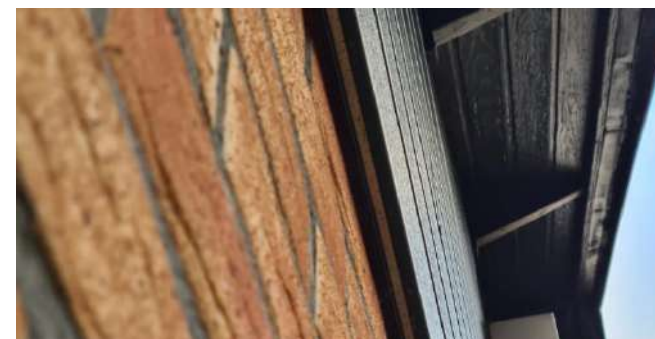
Figuur 6: Detailopname gevelbetimmering en dakrand
