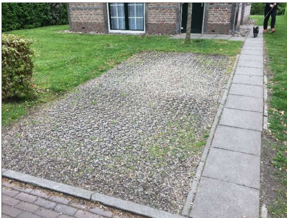
Afbeelding 17: Voorbeeld drukverdelende fundering;
