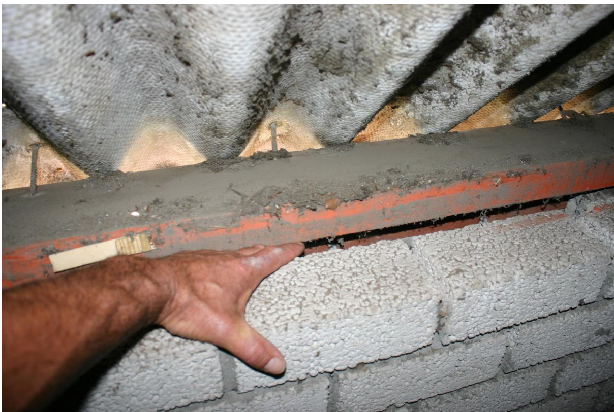
Figuur 4.2.3. De rode pijlen geven de kieren aan waar kleine zoogdieren naar binnen kunnen.
