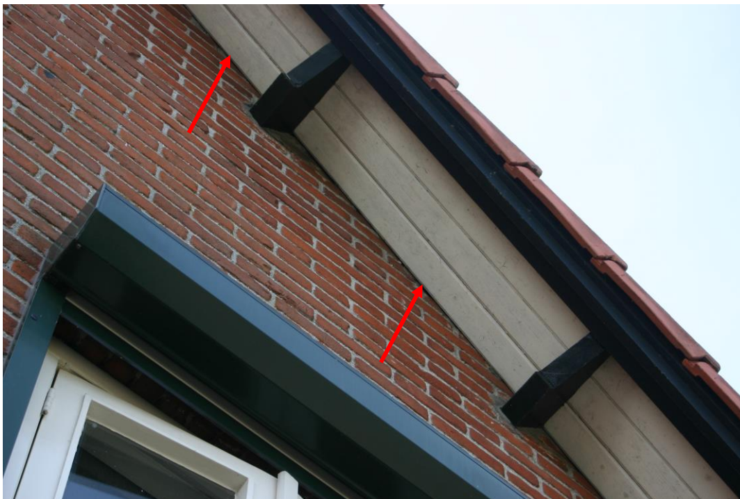
Figuur 4.2.1. De rode pijlen geven de kieren aan waar kleine zoogdieren naar binnen kunnen.
