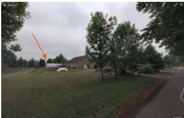
Foto 6: kas op het perceel van Burgt 10
