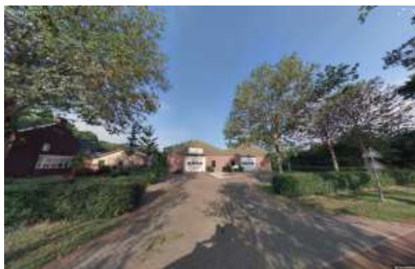
Foto 5: installatiebedrijf aan het adres Bovenstehuis 1
