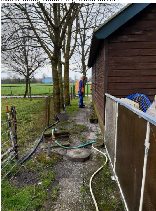
Omschrijving: Asbestverdachte dakbedekking zonder regenwaterafvoer
