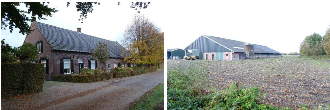
Afbeelding 7 en 8: Te slopen bebouwingen en verwijderen beplantingen op de locatie: Lage Raam 4. Bron: BNL Advies
