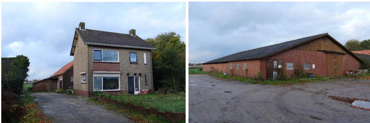
Afbeelding 9 en 10: Te slopen bebouwingen en verwijderen beplantingen op de locatie: Lage Raam 6. Bron: BNL Advies
