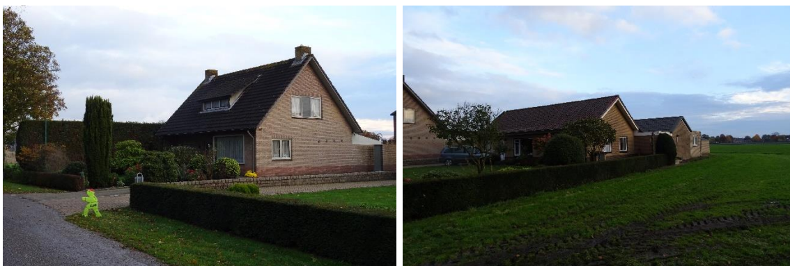
Afbeelding 5 en 6: Te slopen bebouwingen en verwijderen beplantingen op de locatie: Lage Raam 1 & 3. Bron: BNL Advies
