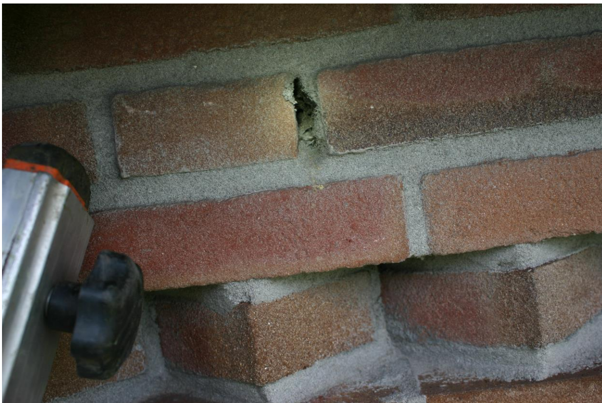
Figuur 4.2.1. Met spinnenrag gevulde open stootvoeg.
