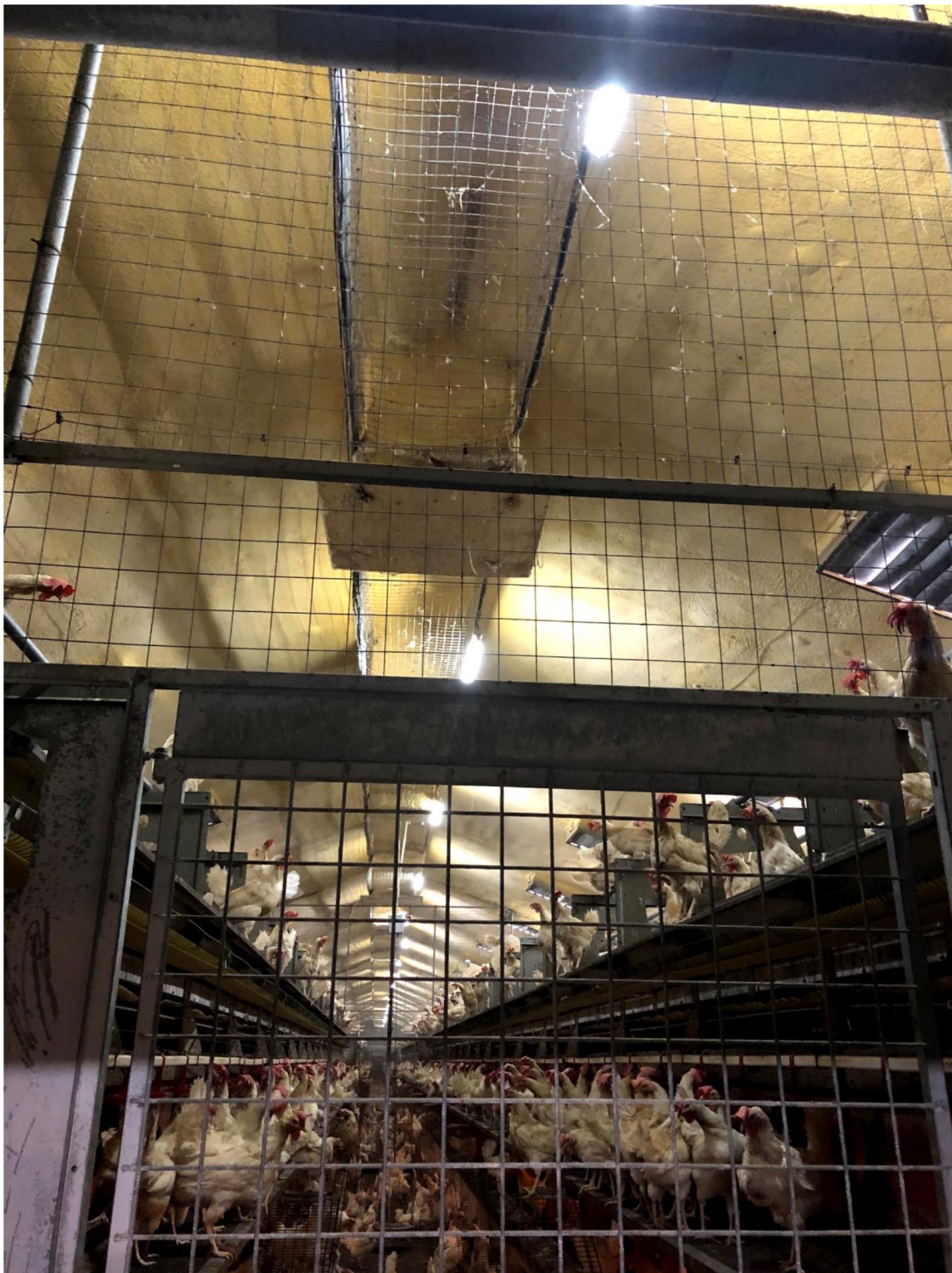
Stal met kippen en in het dak EPS isolatie aangebracht
